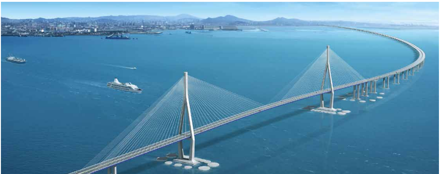
Eine der weltweit grössten Brücken ihrer Art, die Incheon-Brücke in Südkorea, ist mit mageba Dehnfugen ausgestattet.
